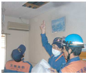
消防署による工事中間検査
